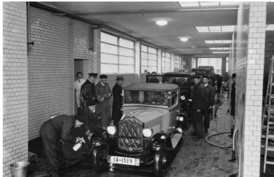
Auto-Waschstraße (1929) Architekt: Heinrich Kosina
