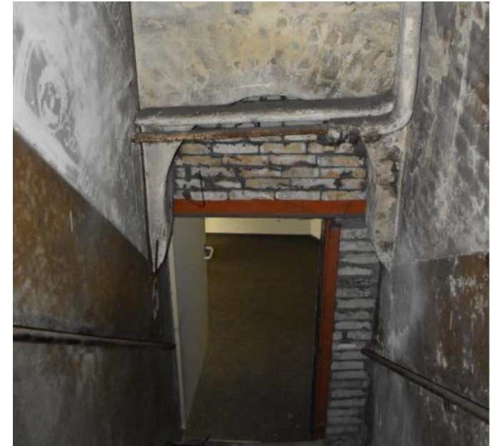
Geb. 05. TH6 treppenhauseitig
