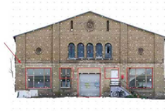
Abb. 02.38. Foto 2019. Westfassade. Fensteröffnungen von 1927, mehrfach überformt, Spuren der Befestigung des Vordachs erhalten (Pfeil)
