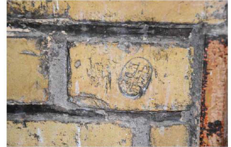
Fundstelle: Stallgebäude 03 Kopfbau Nordfassade (Bereich der Überdachung zu Geb. 35)
