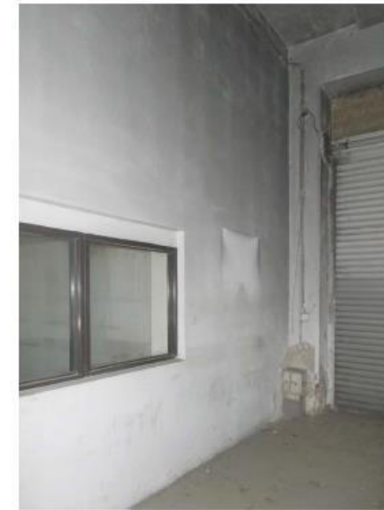
Abb. 3: Eingangsbereich der Werkhalle mit Pförtnerloge. Für die Trennung von Erd- und Obergeschoss (nach 1945) wurde der Zugang an die Giebelseite verlegt und der Durchgang (zwischen Fenster und Tor) verschlossen. Bis dahin konnte der Zugang zum Obergeschoss aus dem Pförtneraum mit überwacht werden.
