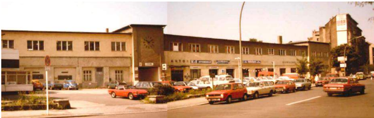
Abb. 46 Fotodokumentation zum Zustand 1985 (Landesdenkmalamt Berlin)
