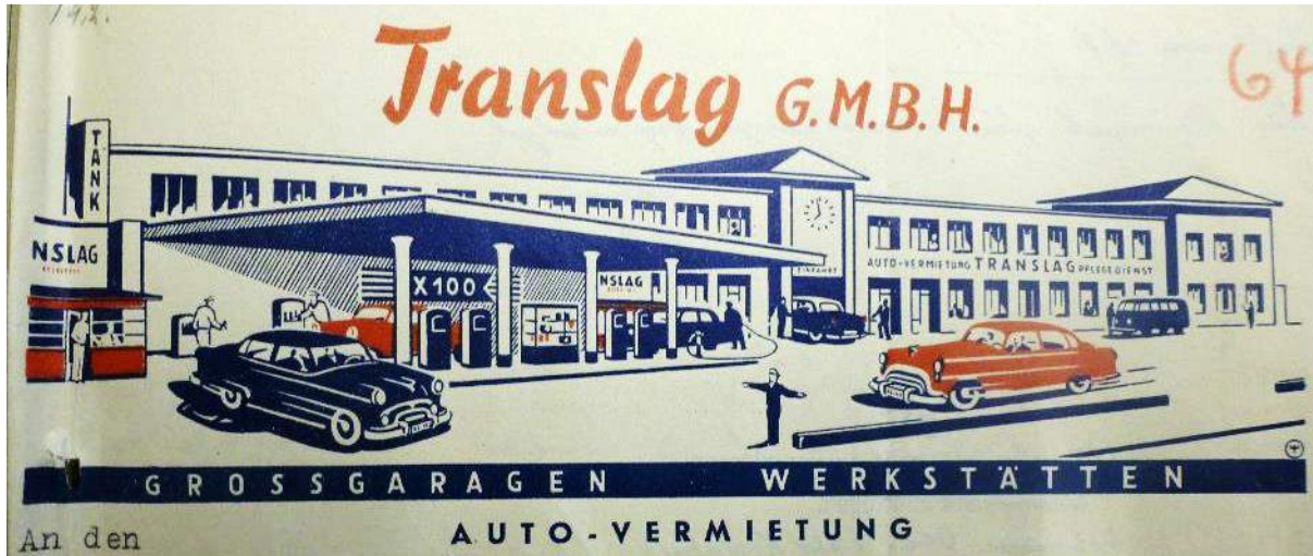
Abb. 45 Briefkopf der Translag GmbH 1958 (Ausschnitt) mit idealisierter Darstellung des Gebäudes an der Obentrautstraße (Bauaktenkammer Friedrichshain-Kreuzberg)
