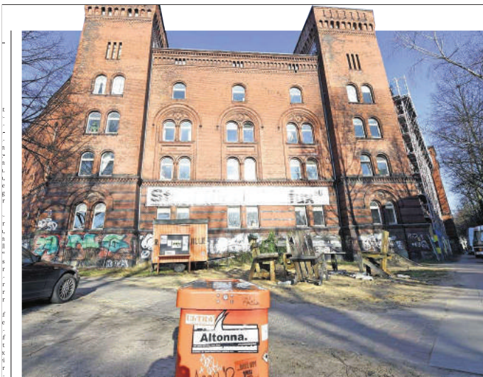
Das Gebäude an der Bodenstedtstraße war einst der Block III der Kaserne. Hier entsteht ein Zentrum für Handwerker, Künstler und Bildungsträger. (Hans Böck)
