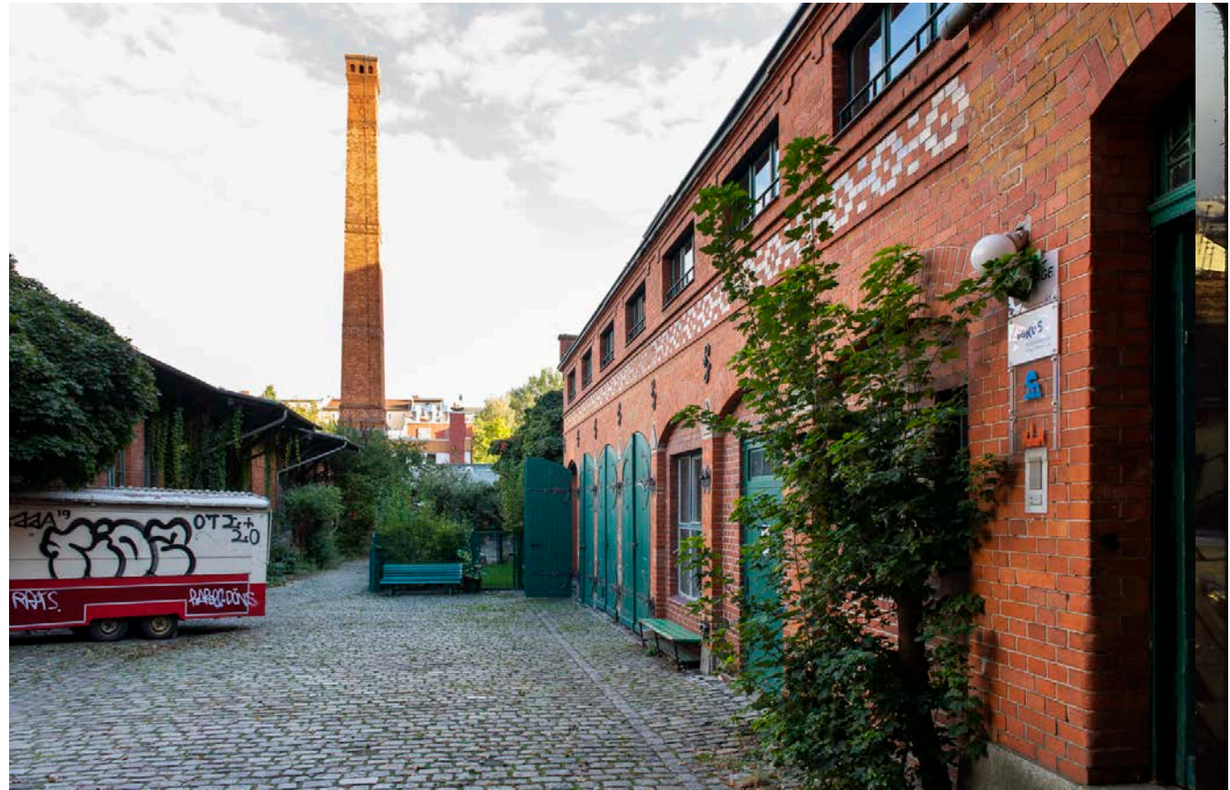
Ehemalige Desinfektionsanstalt Ohlauer Straße, DESI & Theater Expedition Metropolis
