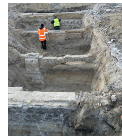
Funde im Zuge der Abrissarbeiten © GPLANT GmbH
