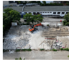
Abrissarbeiten im Baufeld Süd © GPLANT GmbH
