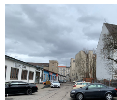
Gebäude Nr. 15 + 15a – Werkstattgebäude (aus dem Jahr 1954) © BIM GmbH
