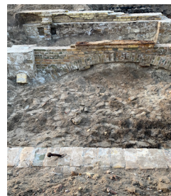
Freigelegte Fundamente im Boden © BIM GmbH
