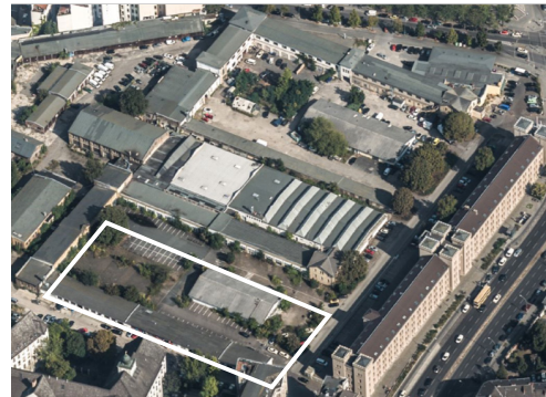
Betroffene Gebäude auf dem Baufeld Süd © BIM GmbH
