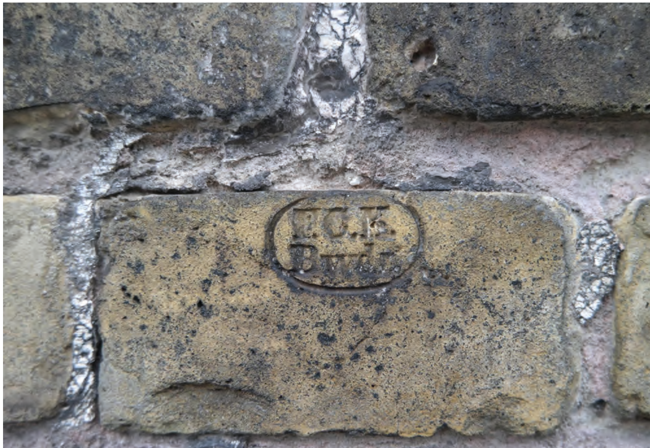
Abb. 13: Bauzeitliches kasernenzeitliches Sichtmauerwerk mit Ziegelstempel, BSQB/SDARC
