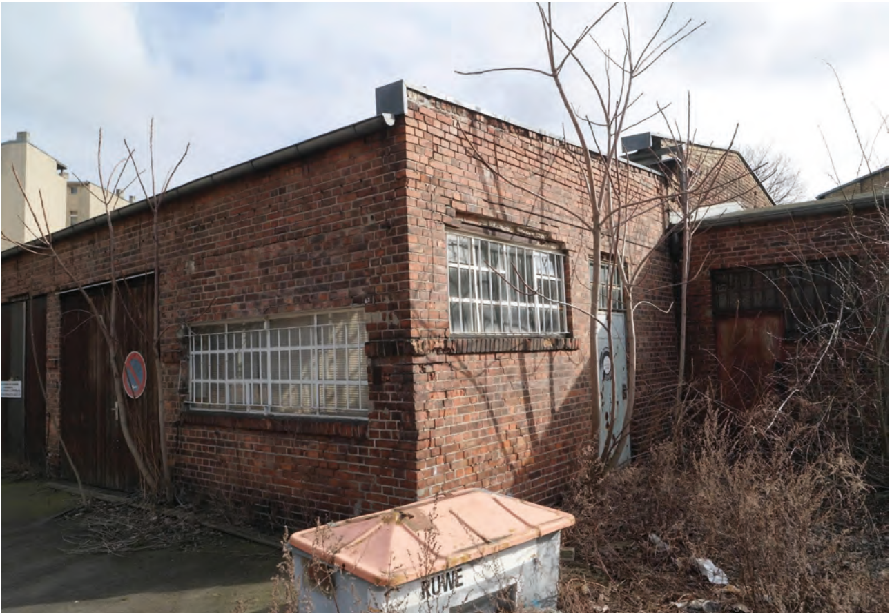
Abb. 15: In diesem Werkstattgebäude ist in Teilen substanzuell noch die alte Schmiede der Kaserne enthalten. Umbau und Veränderung statt Abriss und Neubau, BSQB/SDARC
