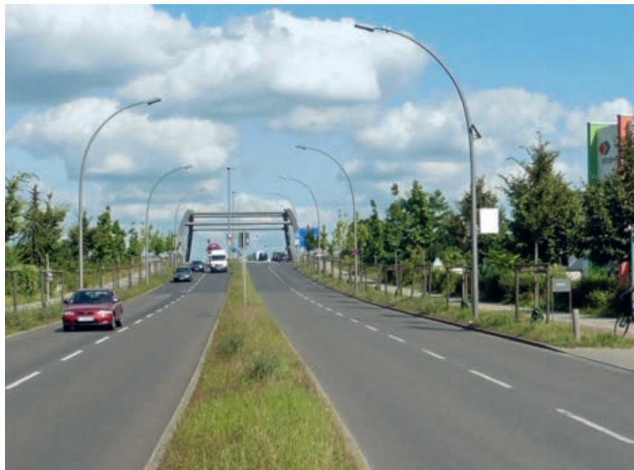
Abb. 1: Gesamtansicht Neue Späthstraße
