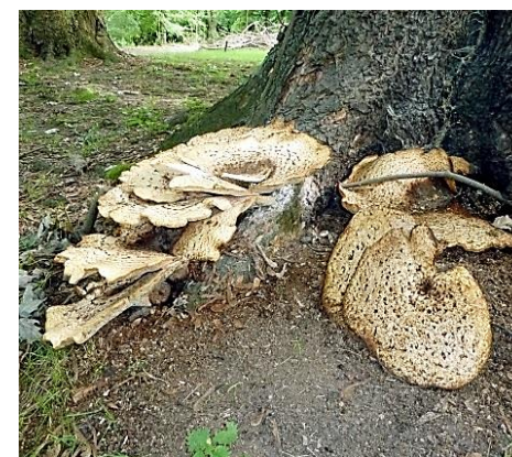
Abb. 2: Schuppiger Porling im Stammfußbereich eines Silberahorns
