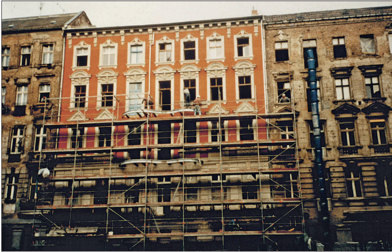
Rykestraße 14, mit eingerüsteter Fassade, November 1994 © M. Schroedter
