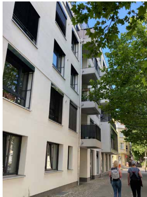
Blick auf neue Wohngebäude in der Hauptstraße
