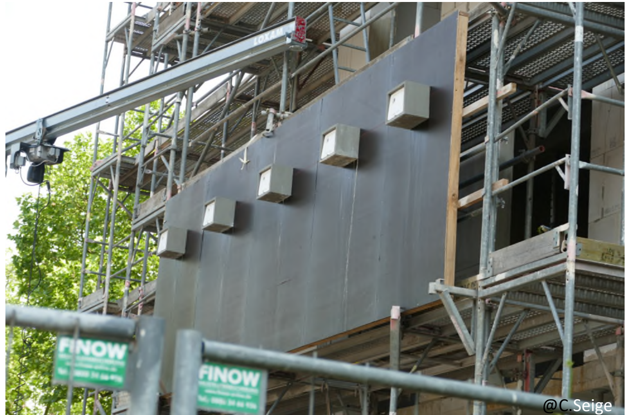
Nistwand am Baugerüst in Pankow 2023
