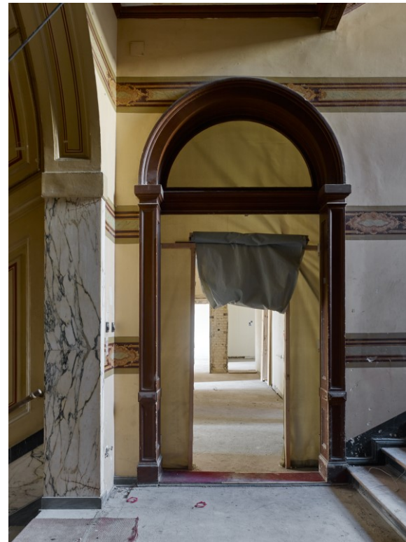
Treppenhaus, 2016, Foto Stefan Müller
