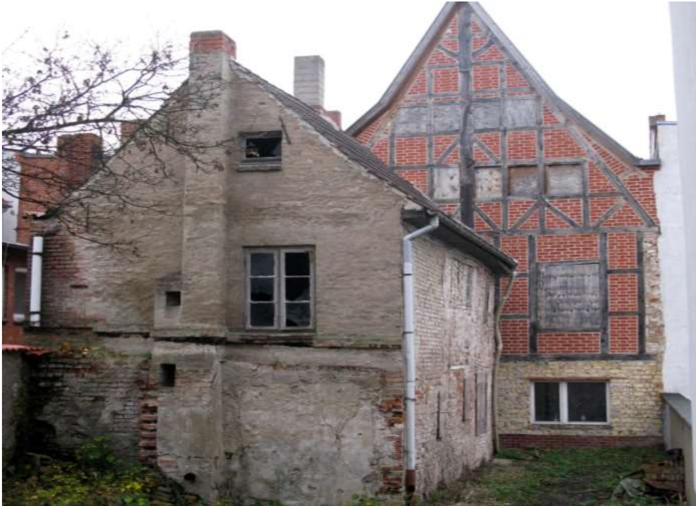
Historische Mauerwerkswand, neu ausgefachte Fachwerkwand
