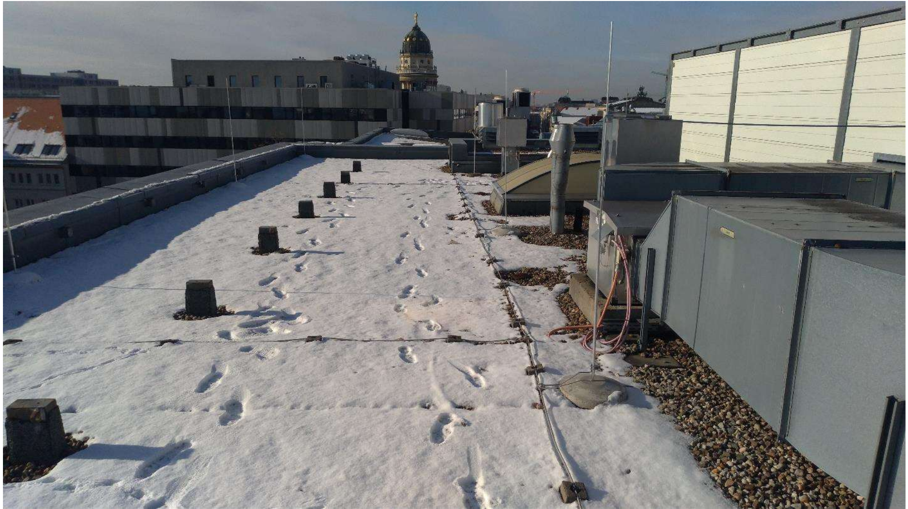
Dachfläche vor der Maßnahme: Bekiesung und Haustechnikanlagen
