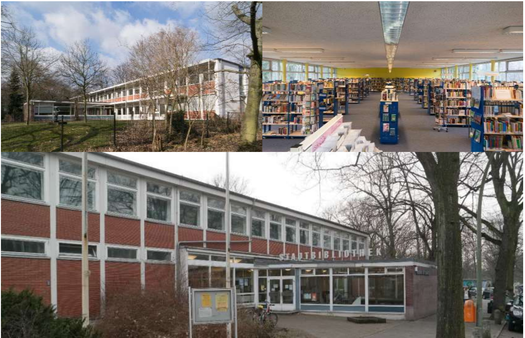
Solarstromerzeugung für den Eigenbedarf (Objekt vor Einbau der PV-Anlage)
