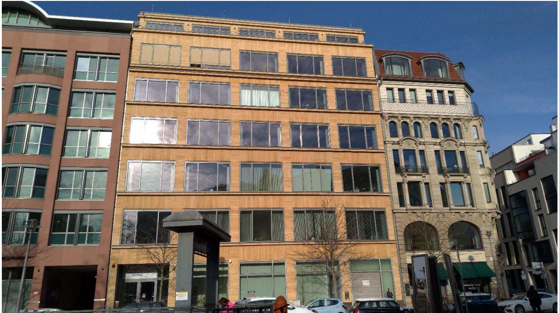
Geschäftshäuser aus den 1930er Jahren (mitte) und der Jahrhundertwende (rechts). Fast vollständig überbaute Grundstücke
