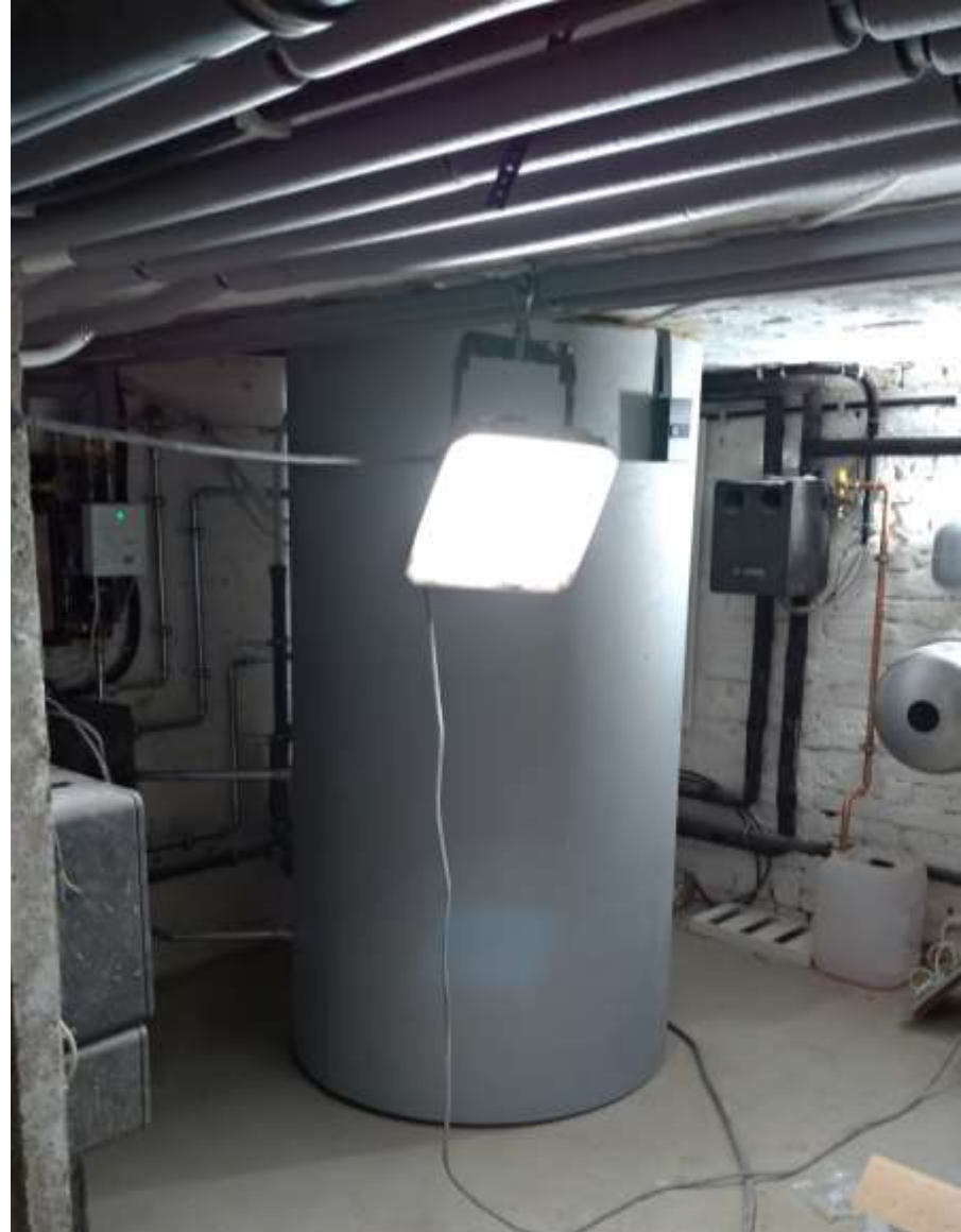
Heizung + Warmwasser: Gasbrennwerttherme + Thermische Solaranlage
