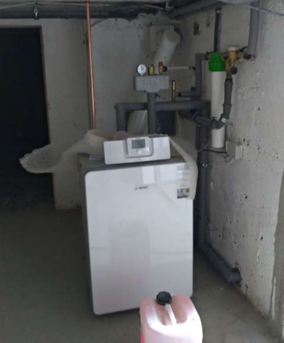
Heizung + Warmwasser: Gasbrennwerttherme + Thermische Solaranlage
