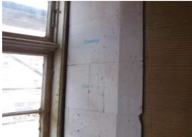
Wärmeübertragung der Konstruktion, Flankendämmung
