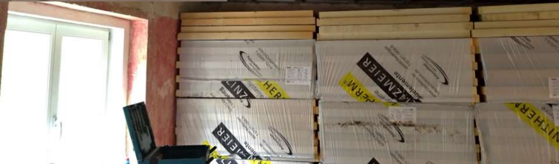
Aufdachdämmung aus hoch wärmedämmenden und statisch belastbaren PU-Dämmplatten
