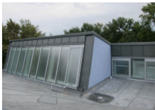
Abb. 8 Das Dach des Verwaltungsgebäudes mit den charakteristischen Shed-Oberlichtern vor und nach der Sanierung, links: undichte Anschlüsse und Abdeckungen machten eine Sanierung zwingend notwendig, Foto: Brenne Architekten, 2010; rechts: das Dach nach der Sanierung, Foto: Brenne Architekten, 2012.
