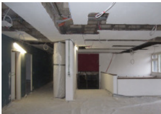
Abb. 9 Das Verwaltungsgebäude während und nach der Sanierung, links: für die zahlreichen Versorgungsstränge und Ertüchtigungen der Bestandsanlagen mussten die Decken zumindest in Teilen geöffnet werden, Foto: Brenne Architekten, 2011; rechts: die bauzeitliche Material- und Farbgestaltung ist wieder in seiner Gänze erfahrbar, große Teile der Bestandsdecken (Rabitzdecken) konnten erhalten werden, Foto: Holger Herschel, 2012.
