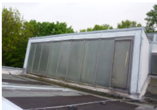
Abb. 8 Das Dach des Verwaltungsgebäudes mit den charakteristischen Shed-Oberlichtern vor und nach der Sanierung, links: undichte Anschlüsse und Abdeckungen machten eine Sanierung zwingend notwendig, Foto: Brenne Architekten, 2010; rechts: das Dach nach der Sanierung, Foto: Brenne Architekten, 2012.
