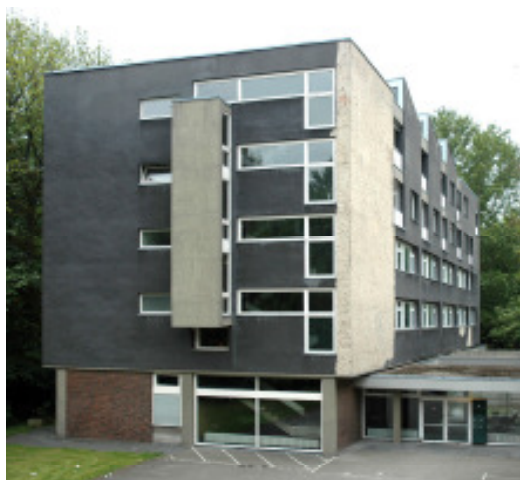
Abb. 7 Das Verwaltungsgebäude vor und nach der Sanierung, links: Putz entspricht nicht der bauzeitlichen Farbigkeit, Putz großflächig abgängig, Foto: Brenne Architekten, 2010; rechts: Fassadenputz mit durchgefärbtem Wärmedämmungsputz komplett erneuert und die bauzeitliche Farbigkeit wiederhergestellt, Foto: Holger Herschel, 2012.
