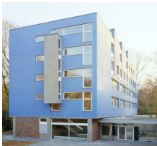
Abb. 7 Das Verwaltungsgebäude vor und nach der Sanierung, links: Putz entspricht nicht der bauzeitlichen Farbigkeit, Putz großflächig abgängig, Foto: Brenne Architekten, 2010; rechts: Fassadenputz mit durchgefärbtem Wärmedämmungsputz komplett erneuert und die bauzeitliche Farbigkeit wiederhergestellt, Foto: Holger Herschel, 2012.
