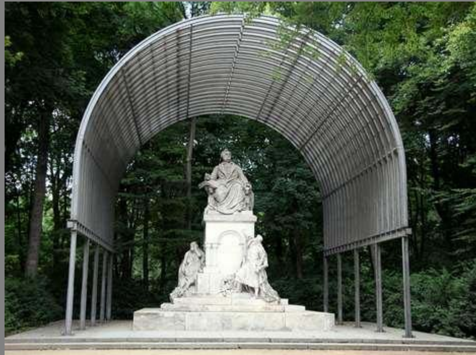
Wagner Denkmal mit Schutzdach
