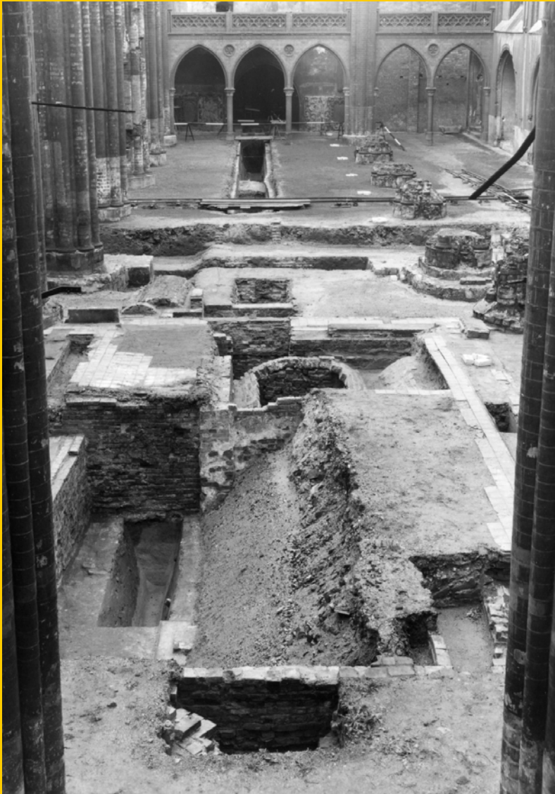
Blick vom Chorumgang in Richtung Turm während der Ausgrabungen 1956
