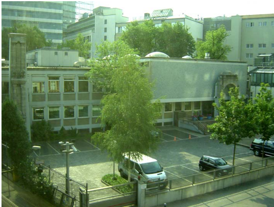
Das Jüdische Gemeindezentrum von der S-Bahn aus gesehen. Foto: Ingolf Herbarth, 2007
