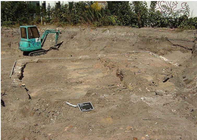
Abb. 15: Berlin Wallstraße, Fundamente einer Scheune, von Südwest
