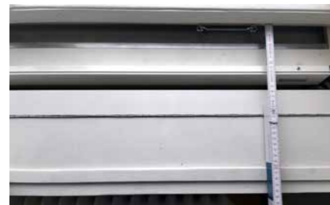
Abb. 3: Brüstung (von oben fotografiert) mit eingefahrenem Rollo
