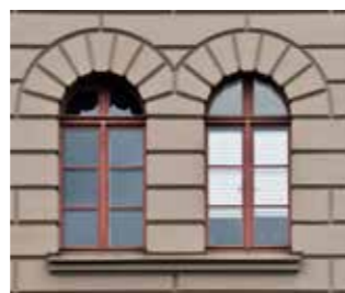
Garde-Drögoner-Kaserne (Finanzamt Kreuzberg) Plissee-Lösung
