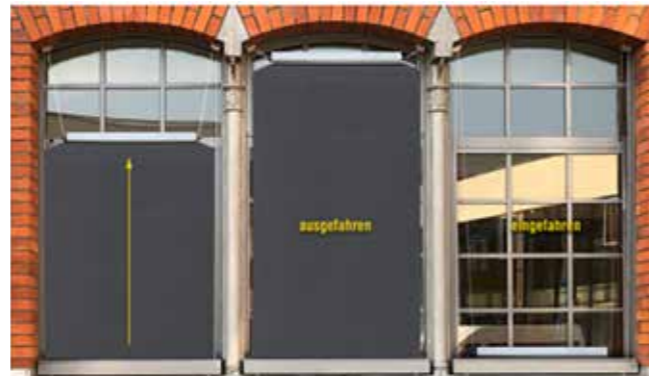
Beispiel für eine von unten nach oben laufende Vertikalmarkise – ehemaliges Nadelwerk Ichttershausen
