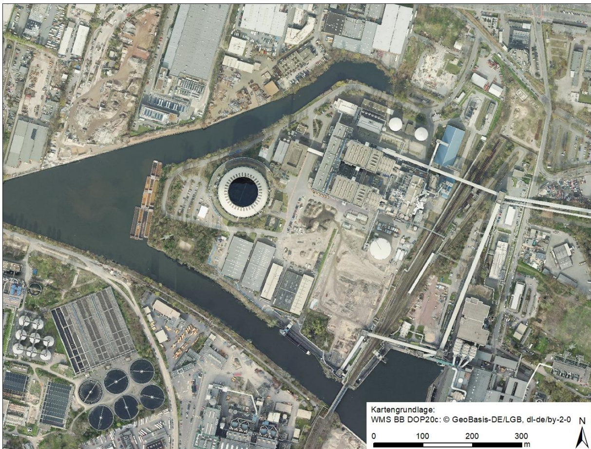
Abbildung 7: Lage HKW Reuter West. Der Standort ist weitgehend von der Spree und Nebenarmen umgeben.
