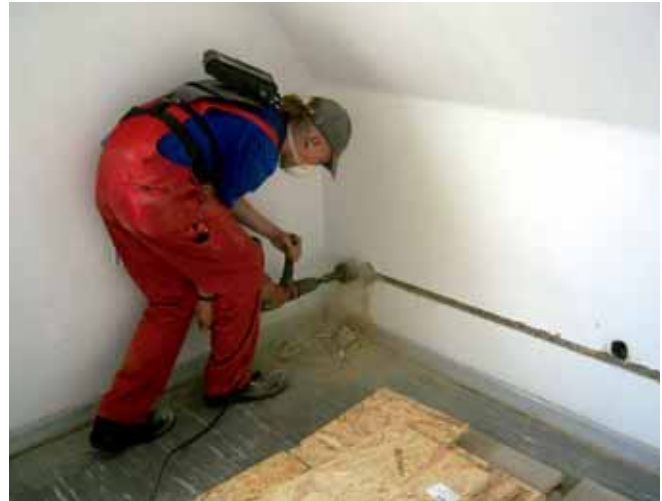
Dosensenken ohne Absaugung mit deutlich erkennbarer Staubentwicklung
