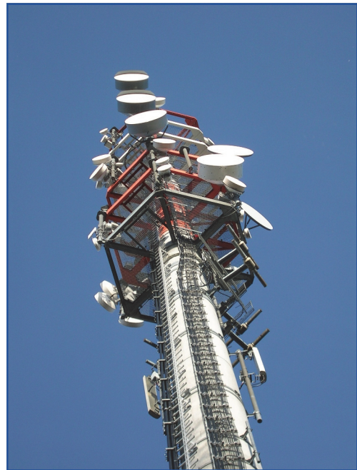
Richtfunk-Antennenanlage (Quelle: picpic/pixelio)
