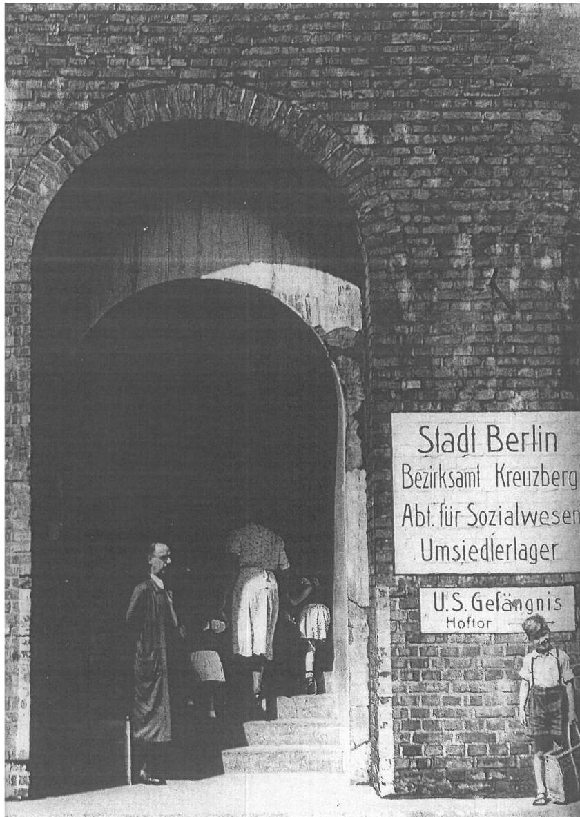
Eingang des ehemaligen Luftschutzbunkers in der Fichtestraße, undatiertes Foto, zweite Hälfte der 1940er Jahre
