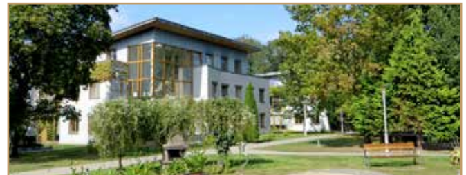
Neubau JVA Hakenfelde
