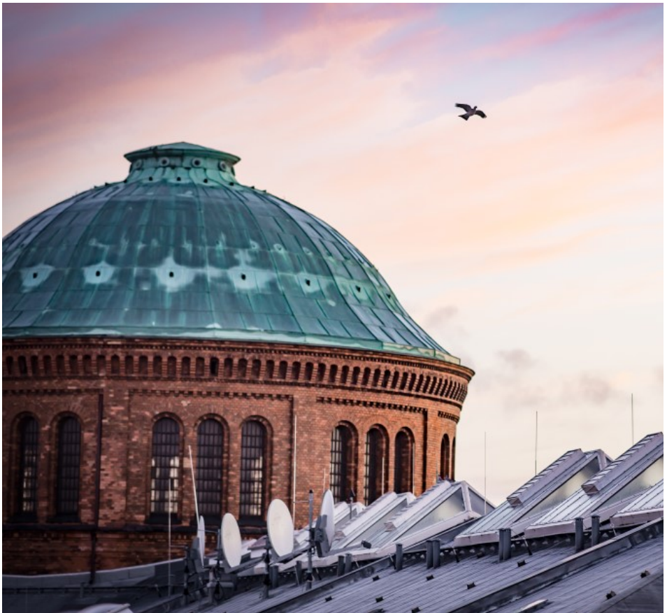
Blick auf die Kuppel der Teilanstalt 1
