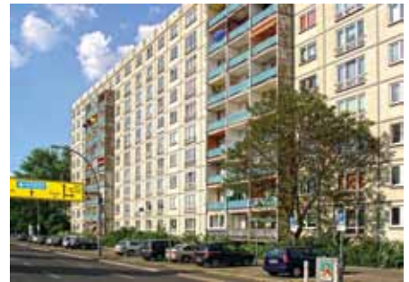
Abb. 47: Betonplattenbauten des komplexen Wohnungsbaus im östlichen Stadtgebiet Berlins
