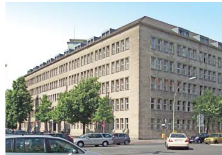
Ansicht des Gebäudes Fehrbelliner Platz 1
