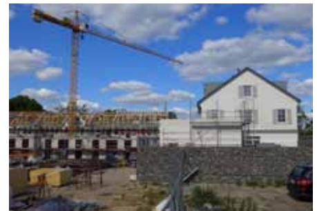
Abb. 25: Wohngebäude in geschlossener Bauweise im Ortsteil Kreuzberg, Riehmers Hofgarten
