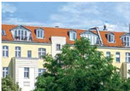
Abb. 48: Wohnung in ausgebautem Dachraum im Ortsteil Wilmerdorf
