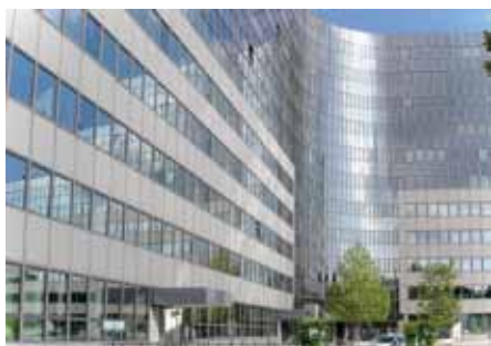
Abb. 38: Büro- und Geschäftshaus
