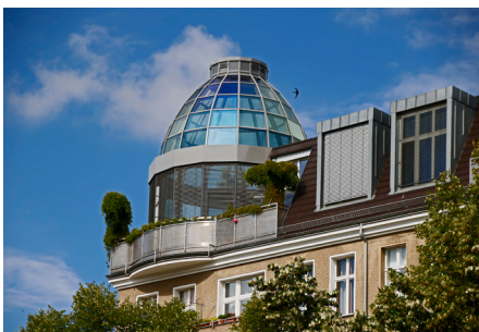
Abb. 48: Wohnung im ausgebauten Dachgeschoss
