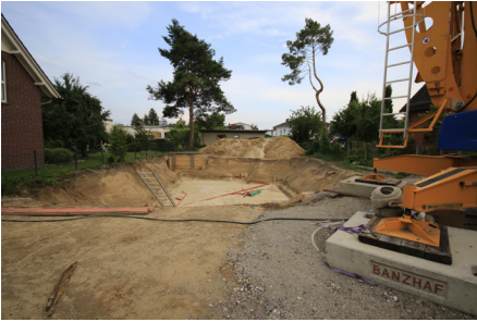
Abb. 21: Wohnbebauung in der offenen Bauweise
