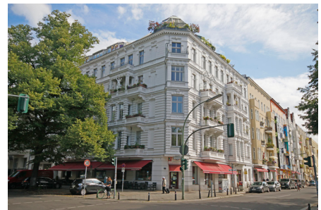
Abb. 30: Wohn- und Geschäftshaus in Charlottenburg,
