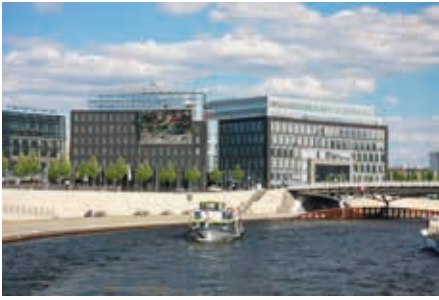
Abb. 31: Büro- und Geschäftshaus
