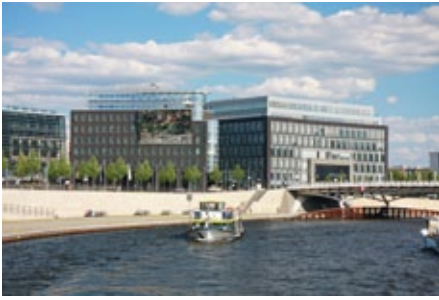
Abb. 30: Büro- und Geschäftshaus
