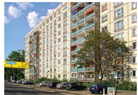
Abb. 42: Betonplattenbauten des komplexen Wohnungsbaus
