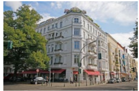
Abb. 29: Wohn- und Geschäftshaus im Ortsteil Charlottenbug, Windscheidstraße/Stuttgarter Platz
