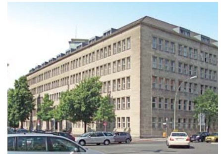
Ansicht des Gebäudes Fehrbelliner Platz 1
