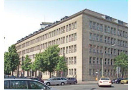
Ansicht des Gebäudes Fehrbelliner Platz 1
