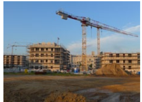
Abb. 18: Wohnbauland: William-H.-Tunner-Straße in Lichtenfelde
