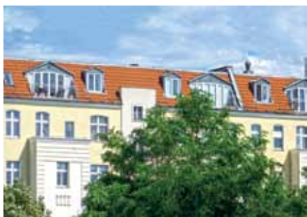
Abb. 40: Wohnung in ausgebautem Dachraum im Ortsteil Wilmerdorf
