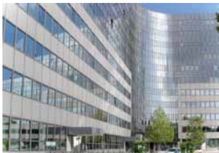
Abb. 29: Büro- und Geschäftshaus
