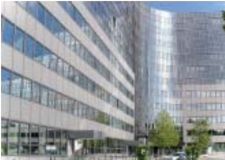
Abb. 38: Büro- und Geschäftshaus
