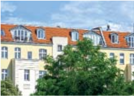
Abb. 48: Wohnung in ausgebautem Dachraum im Ortsteil Wilmerdorf
