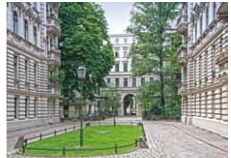
Abb. 24: Wohngebäude in geschlossener Bauweise im Ortsteil Kreuzberg, Riehmers Hofgarten
