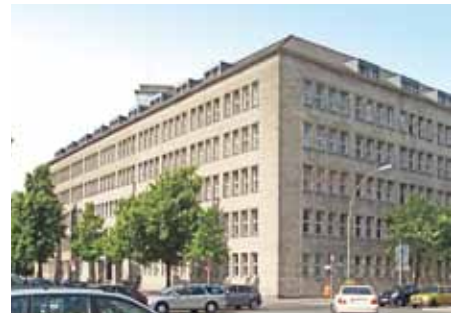
Ansicht des Gebäudes Fehrbelliner Platz 1
