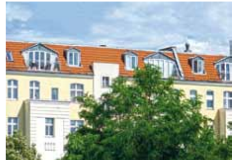
Abb. 50: Wohnung in ausgebautem Dachraum im Ortsteil Wilmersdorf
