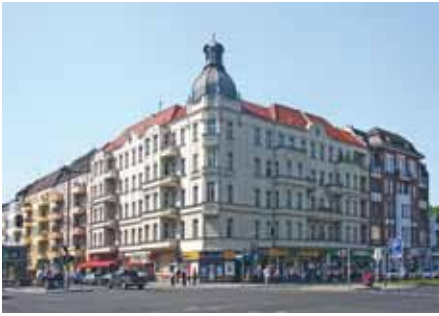
Abb. 38: Wohn- und Geschäftshaus im Ortsteil Wedding, Müllerstraße/Luxemburger Straße
