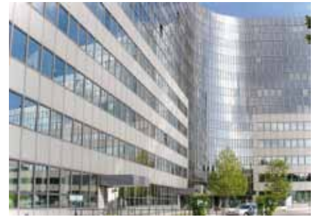
Abb. 39: Büro- und Geschäftshaus
