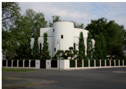
Abb. 17: Beispiel für eine sehr gute Wohnlage im Ortsteil Grunewald
