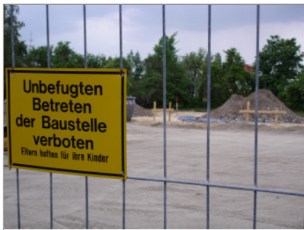
Abb. 18: Baustelleneinrichtung und Bauvorbereitung
