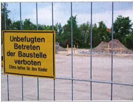
Abb. 18: Vorbereitung eines Grundstücks zur Bebauung
