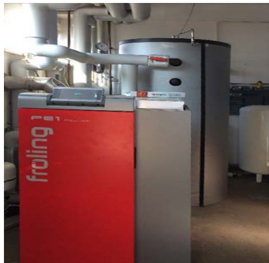
Holzpelletkessel bei der Märkischen Kiste, Quelle: Kofler Energies GmbH
