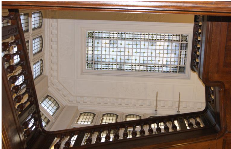
Treppenhaus zur ehemaligen Präsidentenwohnung
