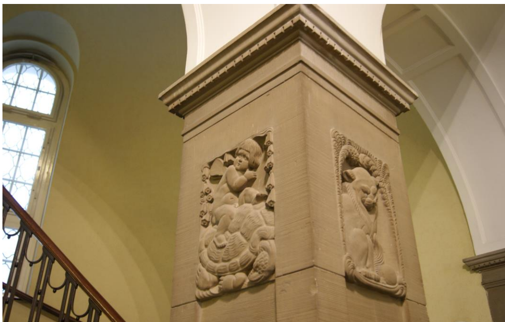
Detail eines Treppenhauspfeilers
