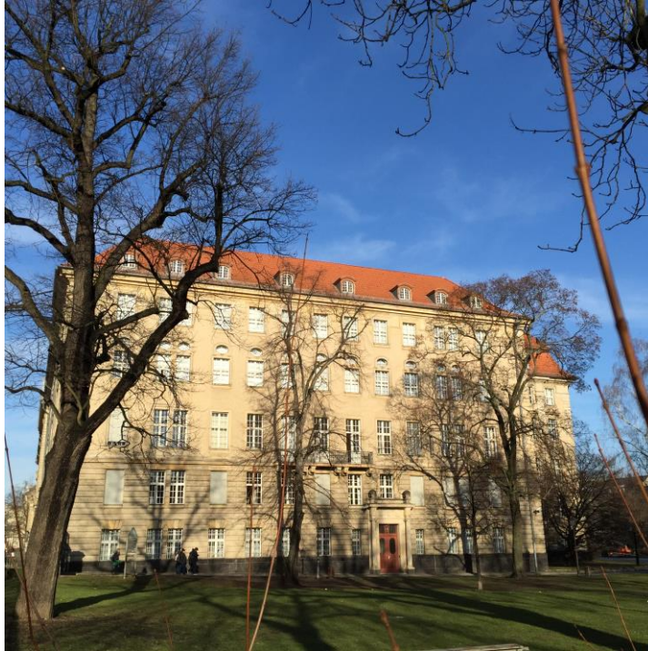
Südfassade des Kammergerichts
