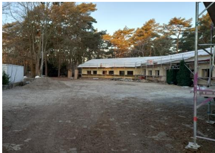
Baustelle „Haus am Badeseesee“ © Bezirksamt Treptow-Köpenick
