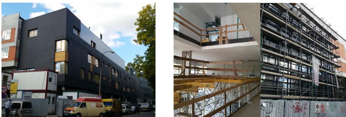
Bild 15: Neubau eines Kulturzentrums
