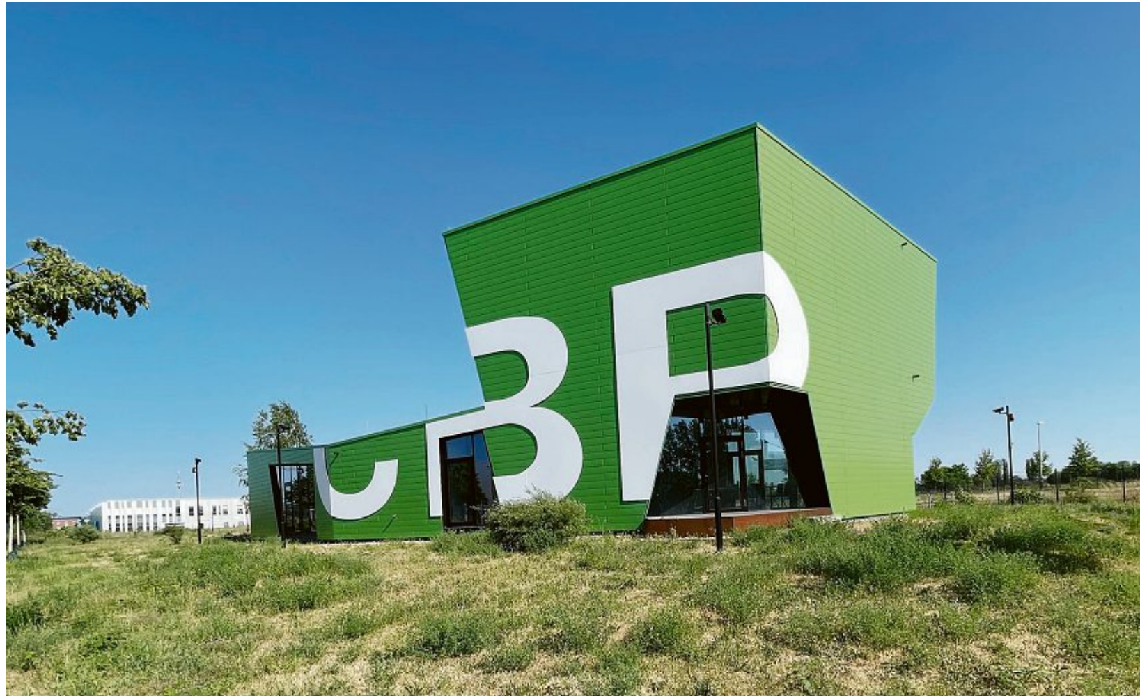
Ein Pavillon im Cleantech Business Park in Marzahn
