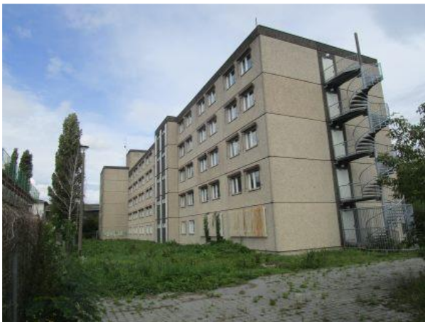
F9: Bürogebäude (leer), Zufahrt, Blick nach Nord-Ost
