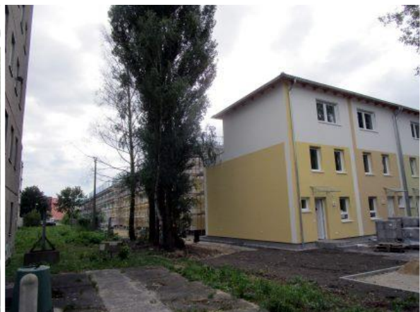
F12: Grundstücksgrenze zum Neubaugebiet, Blick nach Süden
