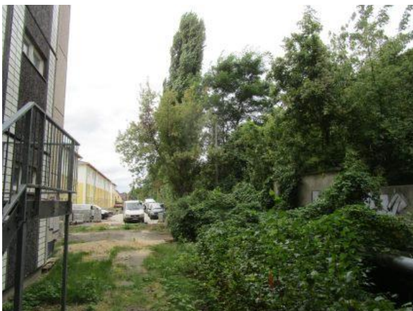
F11: Bürogebäude (leer), Blick n. Westen zum Agnethaweg
