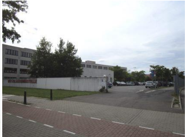
F2: KFZ-Zulassung, Einfahrt von der Ferdinand-Schultze-Str.
