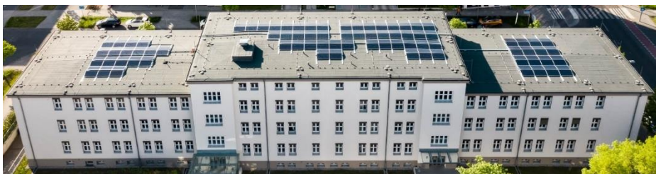
Bürodienstgebäude im Groß-Berliner Damm 154, ©Benjamin Pritzkeleit/Berliner Stadtwerke
