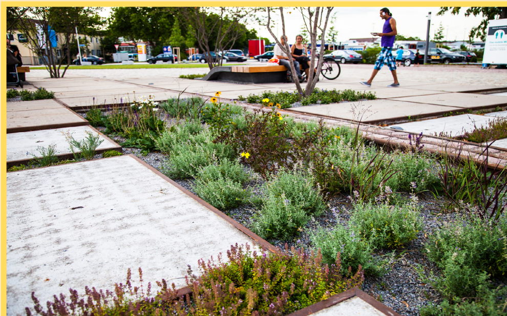
Bepflanzte Versickerungsflächen am Zollhallenplatz in Freiburg i. Br.
