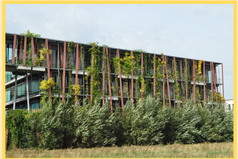
Begrünte Fassade mit vorgelagertem Rankhilfesystem
