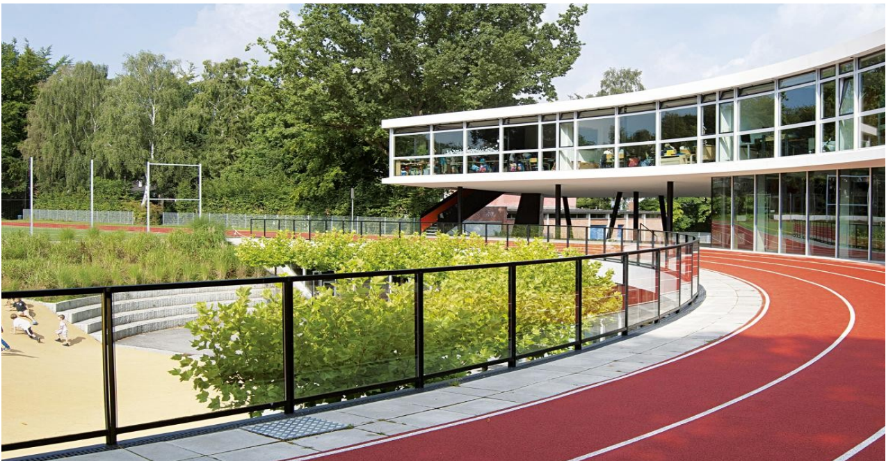
Laufbahn über dem Erdgeschoss einer Grundschule, Gorch-Fock-Schule, Hamburg (Deutschland), die Laufbahn geht von ebener Erde auf das Dach über, https://www.zinco.de/referenz/gorch-fock-schule-hamburg (5.9.2019)
