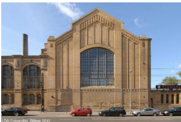
Abbildung 22: Maschinenhalle der KWO Oberspree. Quelle: LDA-Fotoarchiv 2012.
