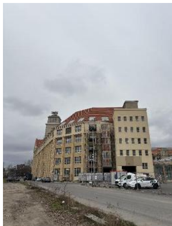
Abbildung 29: Geschossfabrik der Nationale Automobil-Gesellschaft, NAG (Peter-Behrens-Bau). Quelle: eigene Abbildung.
