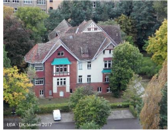
Abbildung 32: Direktorenvilla mit Garten auf dem Werksgelände der AEG Kabelwerke Oberspree. Quelle: LDA-Fotoarchiv 2017.
