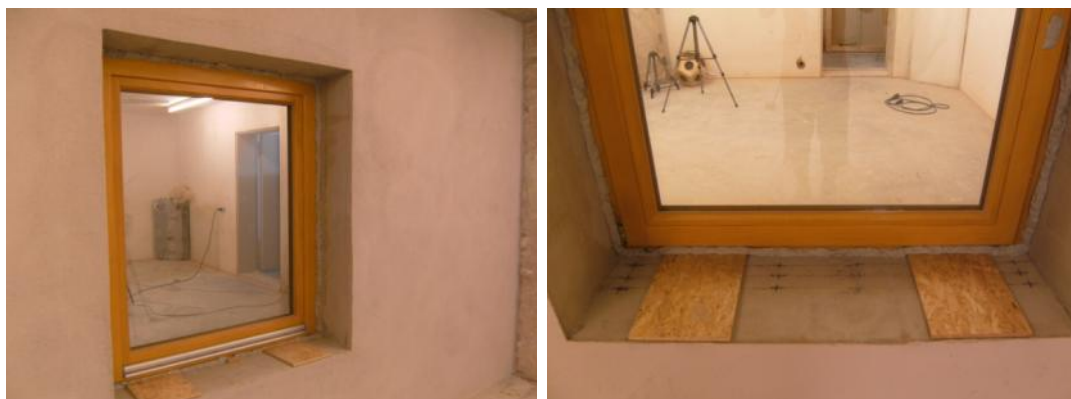
Abbildung A15: Einbausituation im Wandprüfstand der HFT Stuttgart. Massivwand aus Kalksandstein 175 mm mit MineralwollWDVS 280 mm und Außenputz 15 mm.
