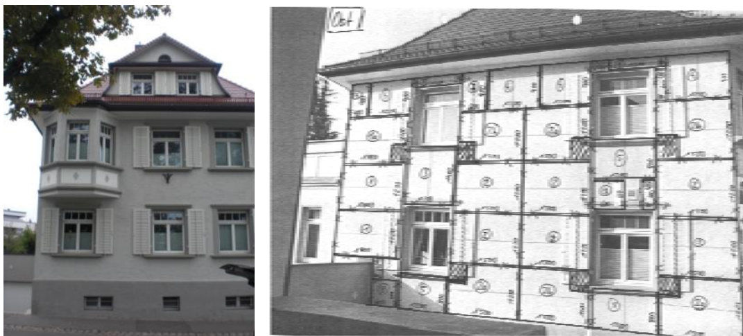
Abbildung A13: Das Gebäude in Weingarten vor der Sanierung (links) und das Aufmaß für die VIP-Paneele (rechts).
