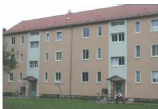
Ohne VIP, Verschattung durch auskragende Balkonplatten
