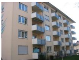
Mit VIP und mit abgesägten Balkonplatten
