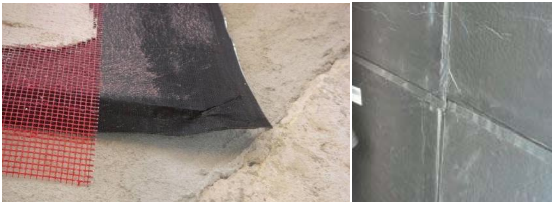
Abbildung W23: Vakuum-Dämmplatte va-Q-plus B der Fa. Va-Q-tec, Anwendung bei einer denkmalgeschützten Fassade (rechts) und Verlegung mit Überlappung (links)
