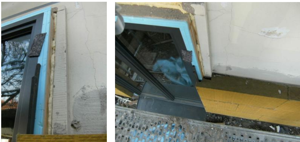
Abbildung A11: Einbausituation Fenstertüre vor Dämmung der Gebäudehülle.
