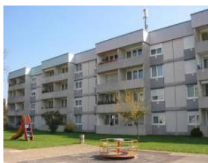
Ohne VIP mit abgesägten Balkonen
